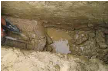
Beim Fundamente graben
