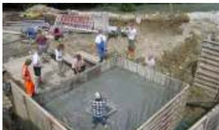
Betonieren der ersten Decke des Turbinenhauses
