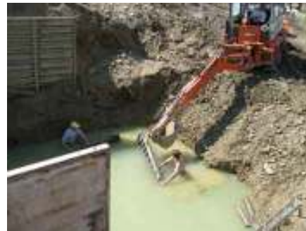
Schalung stellen fürs Turbinenhaus
